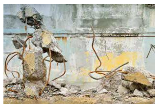
コンクリート解体
